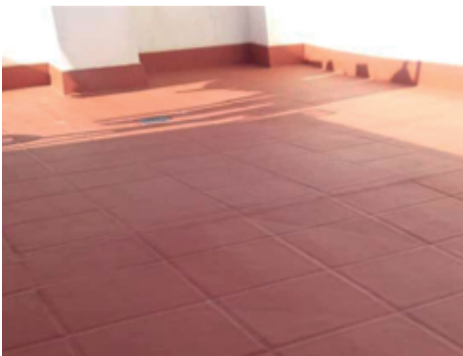
Figura 1. Vista general de la colocación al exterior
